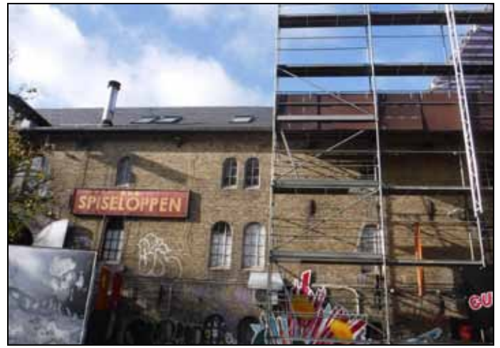
A new slate roof over Spiseløppen
